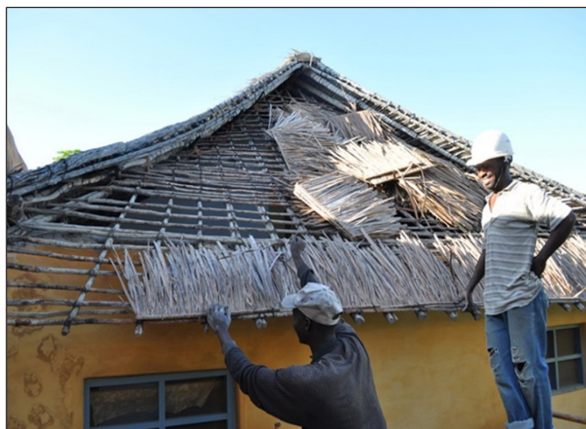
Figura 2 – Construção de telhado macuti.
