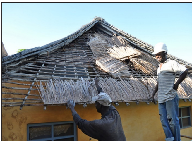
Figura 2 – Construção de telhado macuti.
