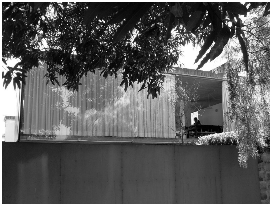
Figura 03 – Casa Mello. Fonte: Acervo do Autor, 2008.
