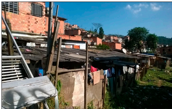
Figura 5: Barracos de madeira e auto-construções em alvenaria. Área em espera do atendimento da CDHU
