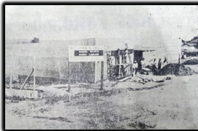
Figura 6 – Construcción del Parque Infantil "Walt Disney"
